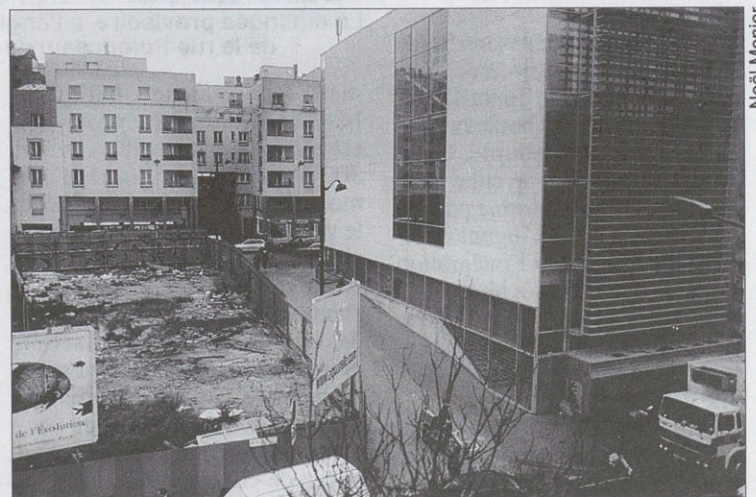
A droite, la nouvelle bibliothèque (dont la construction est achevée et qui ouvrira au printemps). En face, là où devait être édifié l'équipement musical pour les jeunes, un terrain vague.
