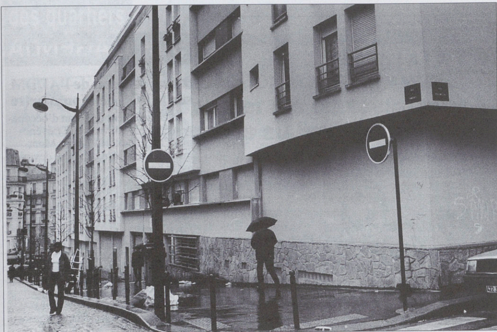
Rue des Gardes : l'OPAC n'a pas réussi jusqu'à maintenant à louer les espaces commerciaux en rez-de-chaussée des immeubles, probablement à cause du prix trop élevé.
