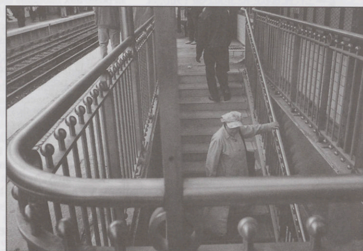
L'arrivée de l'escalier sur le quai de la ligne 2 (Nation-Dauphine). Passage obligé, puisque les escalators ne marchent pas.
