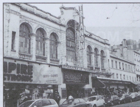
Le Trianon avant les travaux.
