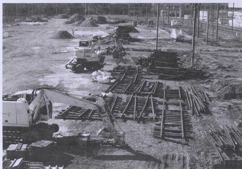
Depuis le pont Riquet, sur le terrain devant la halle Pajol, la dépose des rails a déjà commencé pour faire la place au futur CDG Express.
