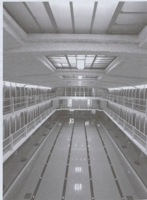
La piscine des Amiraux en 2017, juste après sa rénovation.
